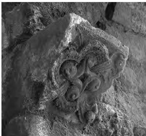
Fig. 32 Voussoir in Park Farm arch
